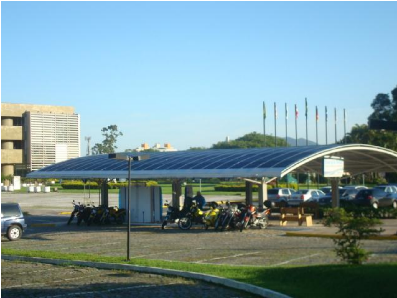
Estacionamento ELETROSUL, 12 kWp
